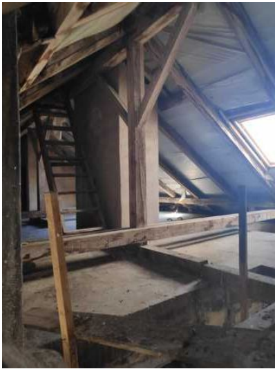
Vstup na střechu z podkrovní
