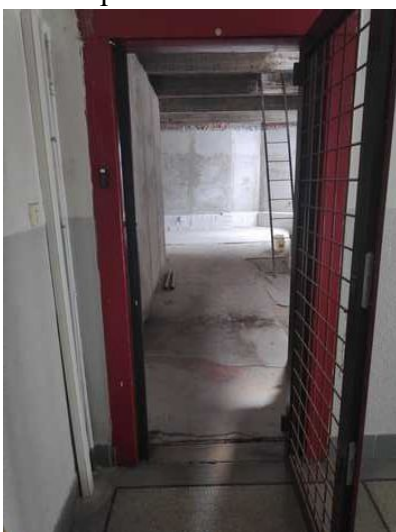
Vstup do jednotky
