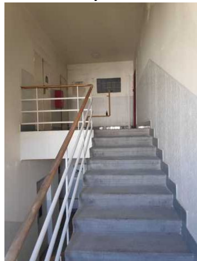
Schodiště do posledního podlaží
